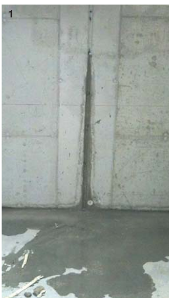
Foto 1) Lesione con fuoriuscita di acqua in spinta idraulica - Foto 2) Predisposizione dei fori per i packer di iniezione - Foto 3) Fissaggio dei packer a tenuta nei fori - Foto 4) Iniezione con pompa elettrica della resina idroespansiva elastica.
