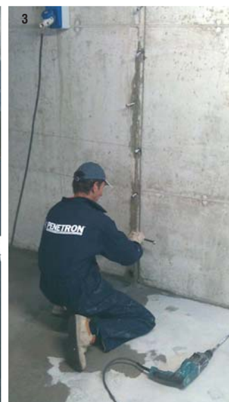
Foto 1) Lesione con fuoriuscita di acqua in spinta idraulica - Foto 2) Predisposizione dei fori per i packer di iniezione - Foto 3) Fissaggio dei packer a tenuta nei fori - Foto 4) Iniezione con pompa elettrica della resina idroespansiva elastica.
