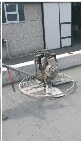
Foto 1) Spolvero su superfici orizzontali fresche di getto - Foto 2) Finitura con elicottero - Foto 3) Fasi esecutive - Foto 4) Maturazione umida delle superfici
