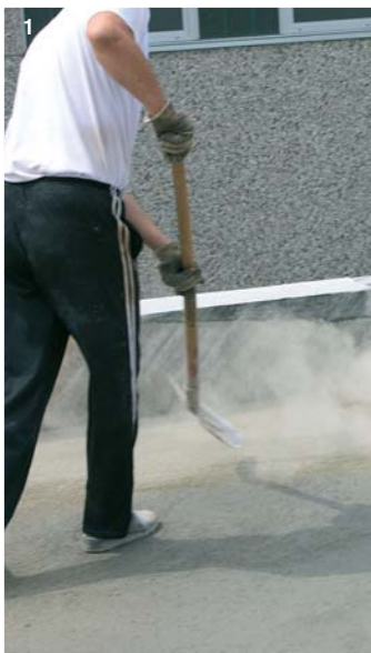
Foto 1) Spolvero su superfici orizzontali fresche di getto - Foto 2) Finitura con elicottero - Foto 3) Fasi esecutive - Foto 4) Maturazione umida delle superfici
