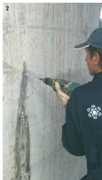
Foto 1) Lesione con fuoriuscita di acqua in spinta idraulica - Foto 2) Predisposizione dei fori per i packer di iniezione - Foto 3) Fissaggio dei packer a tenuta nei fori - Foto 4) Iniezione con pompa elettrica della resina idroespansiva elastica.
