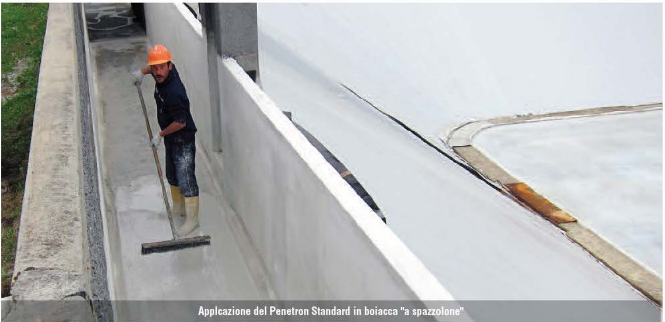
Applicazione del Penetron Standard in boiacca "a pennellata"
