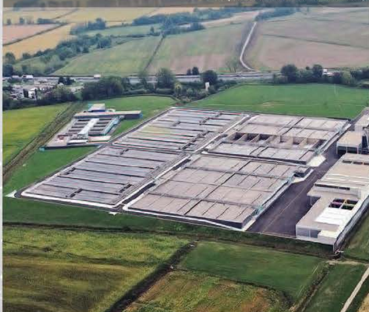
Depuratore San Rocco Milano Sud, Rozzano (MI)
