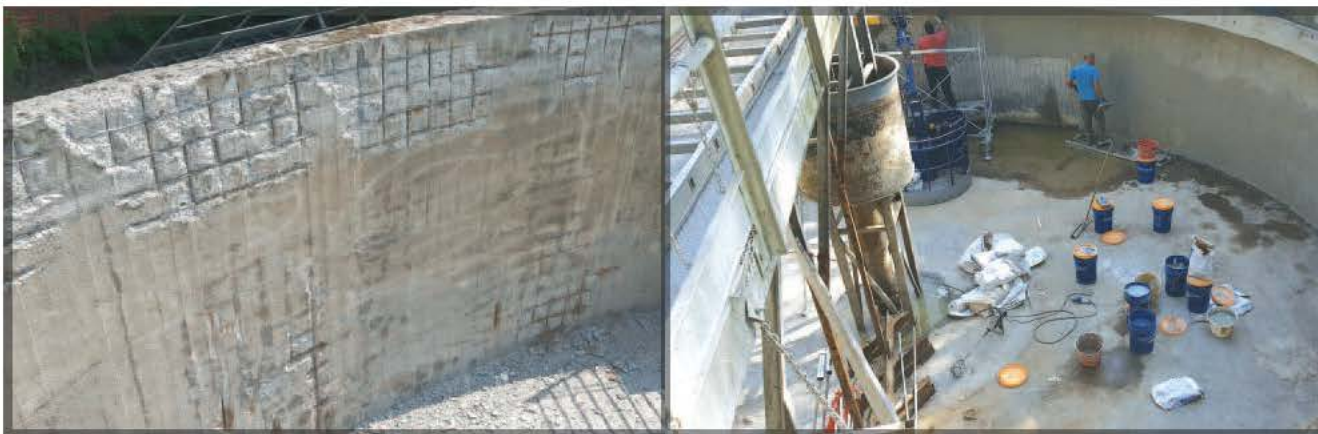
Risanamento strutture interrato sotto falda di lago residence privato, platea e pareti, Pontetresa (VA)
