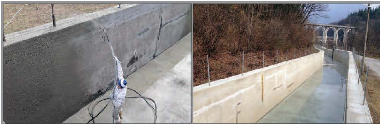
Collettori fognari Via del Nord, Milano
