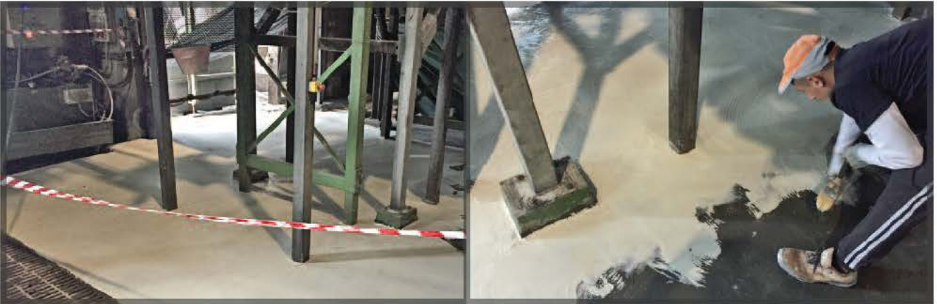
Pavimentazione centrale di compostaggio, ACEA, Pinerolo (TO)
