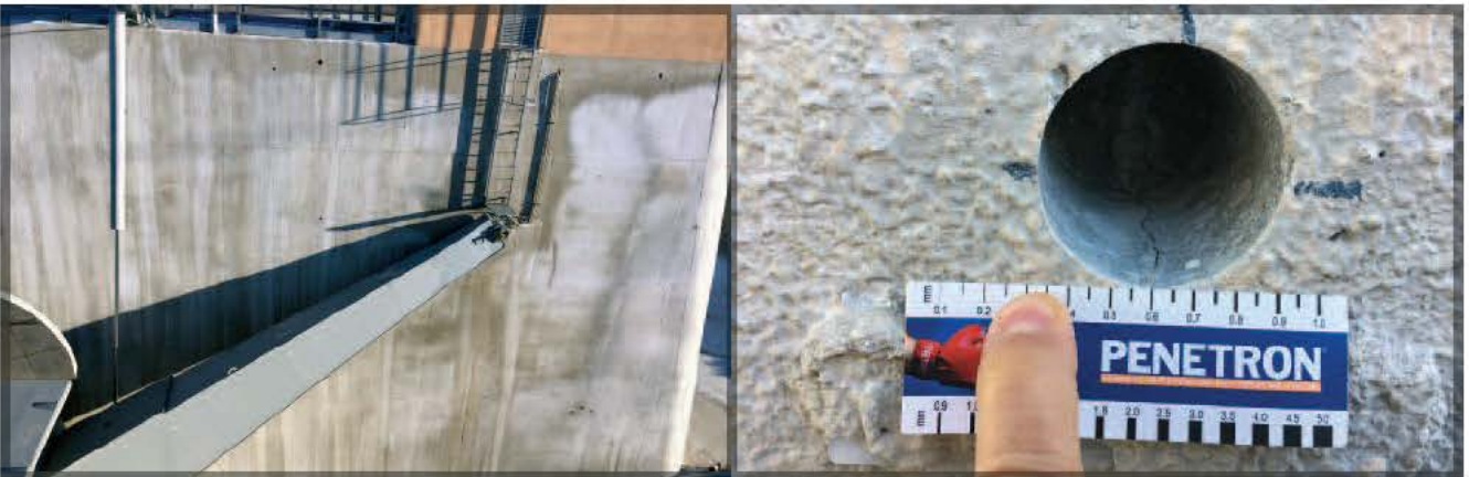
Tattamento speroni fessurati di impianto idroelettrico, Mazzé (TO)
