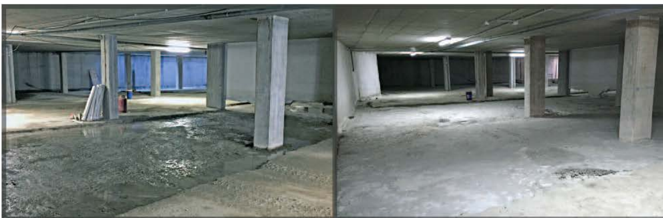
Risanamento strutture interrato sotto falda di lago residence privato, platea e pareti, Pontetresa (VA)
